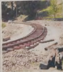
I risultati dei lavori di ripristino (S.A.)
